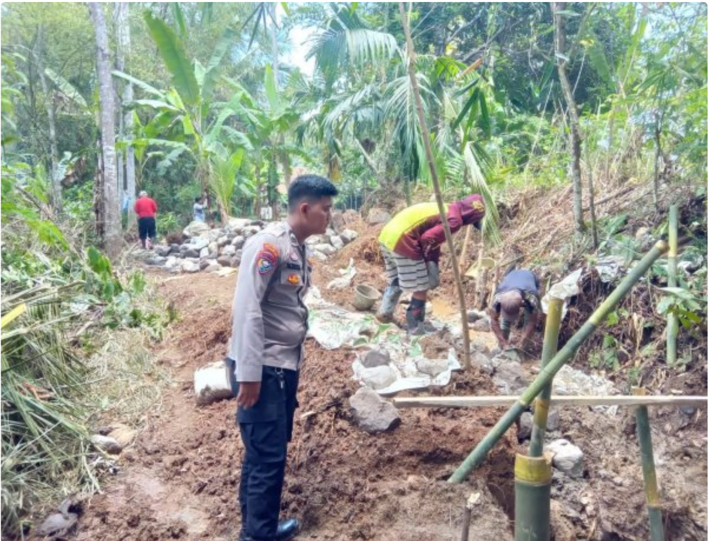
Bhabinkamtibmas Cijengkol Memantau Pembangunan Irigasi di Wilayah Desa
