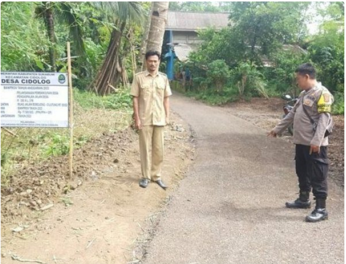
Bhabinkamtibmas Desa Cidolog Awasi Pembangunan Desa
