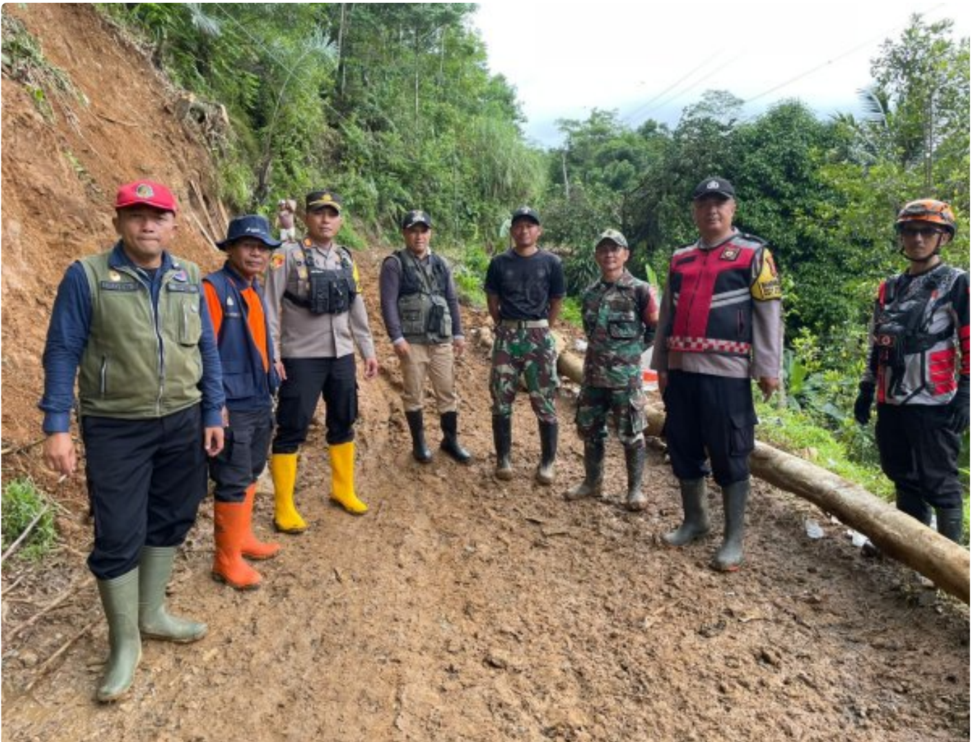
Kapolsek Kalibunder Pantau Operasional Alat Berat untuk Buka Akses Jalan
